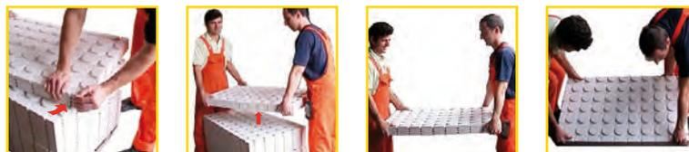
Legen Sie die Kompakt-Platten zuerst an einer Kante, dann komplett auf. Hochkant-Lagerung führt zu Verformungen der Platten und Kantenbeschädigung. Der horizontale Plattentransport im Gebäude ist mit Hubwagen oder anderen Plattentransportwagen möglich.
