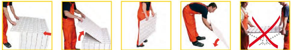
Heben, tragen und legen **mehrerer** Kompakt-Platten (ab 5 Platten):
